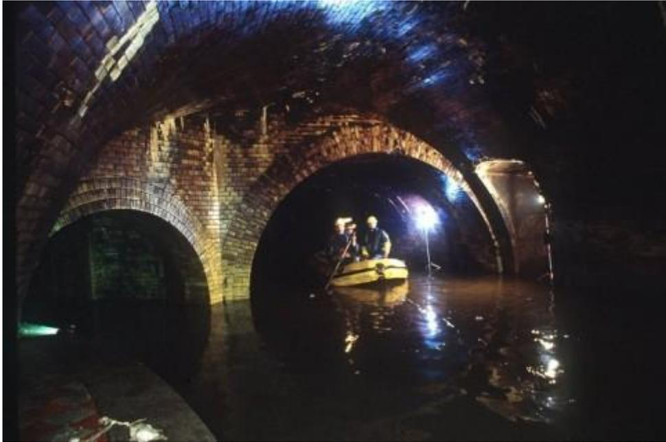
[Foto: dpa](#) Die aus Backstein gemauerten Kanäle der Hamburger Kanalisation gehen auf Pläne William Lindleys zurück
